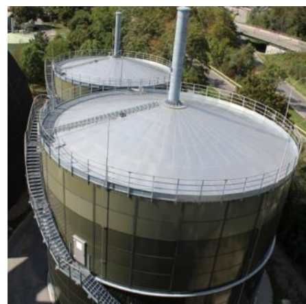
Zentralklärwerk Mainz Niederdruckgasspeicher 55 mbar Volumen: 2.500 m 3 und 3.700 m 3
