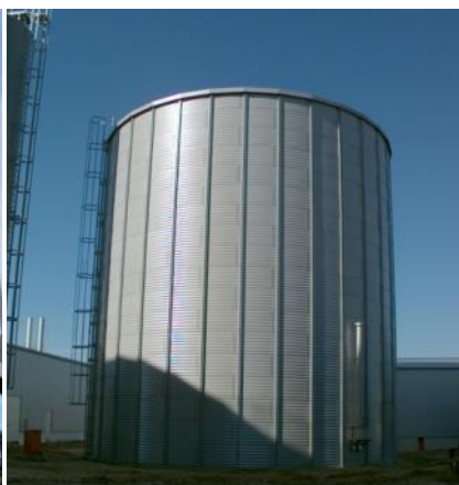
Kläranlage Friedrichshagen Druckloser Speicher Volumen: 2.500 m 3
