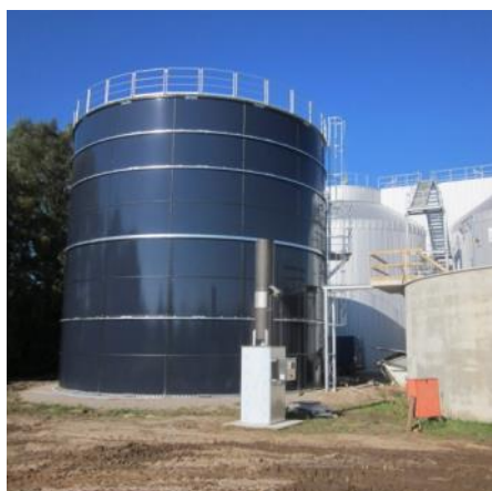
Kläranlage Nordhorn Niederdruckgasspeicher 50 mbar Volumen: 1.000 m 3
