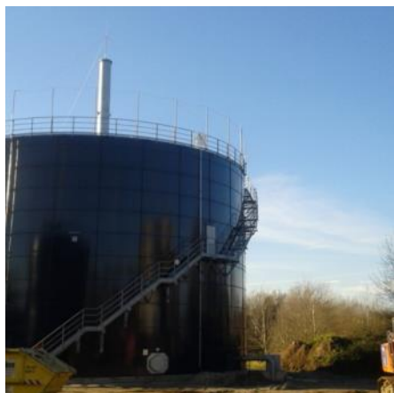
Kläranlage Bremen Seehausen Niederdruckgasspeicher 50 mbar Volumen: 5.000 m 3
