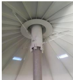
Erneuerung Teleskoprohr
