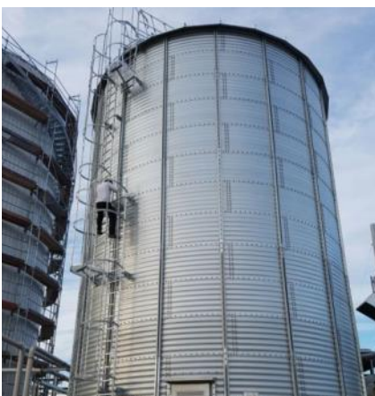
Kläranlage Übach-Palenberg Druckloser Speicher Volumen: 250 m 3
