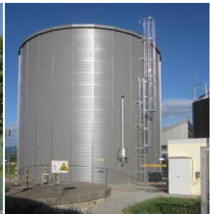
Biogasanlage Edenkoben Druckloser Speicher Volumen: 1.200 m 3
